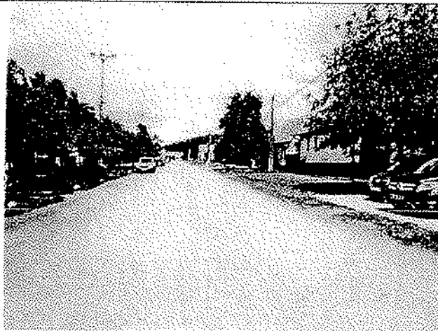
Vedere acces stradal partea din stanga
