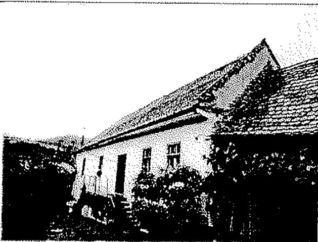
Vedere Exterior Casa(lipsa tencuiala)
